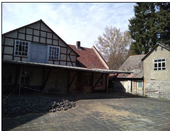
Foto 3: Hof und ehemalige Betriebsgebäude
